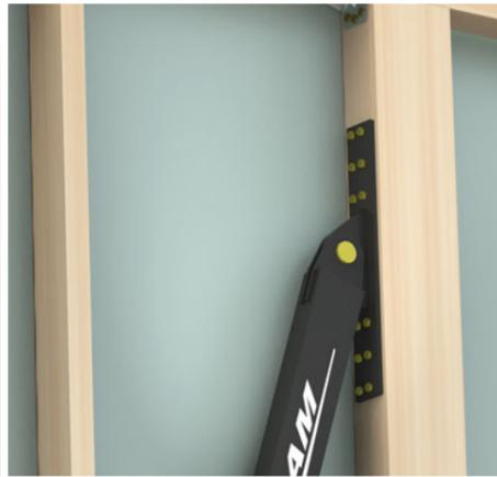
地震の揺れを吸収する制振装置
